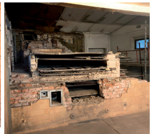
Rozbiórka starego pieca w 2022 roku
