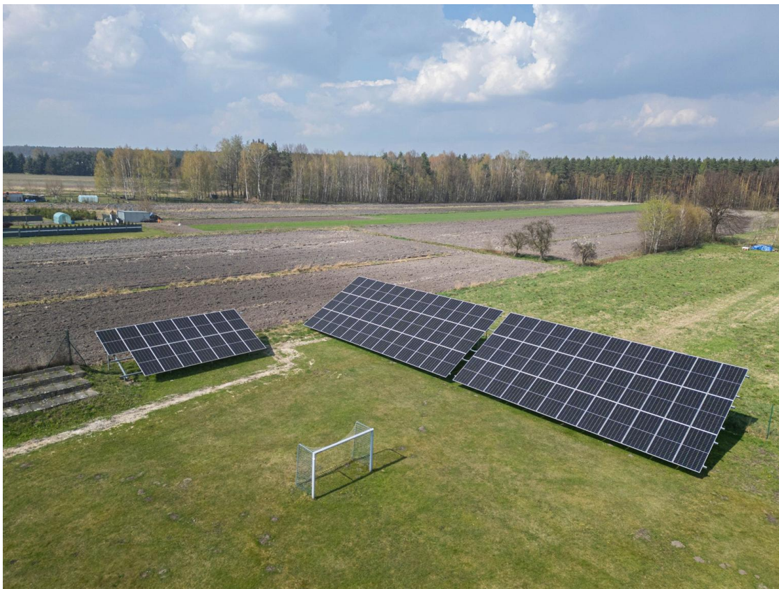
Pompownia Bojszowy Nowe, ul. Ruchu Oporu 100
