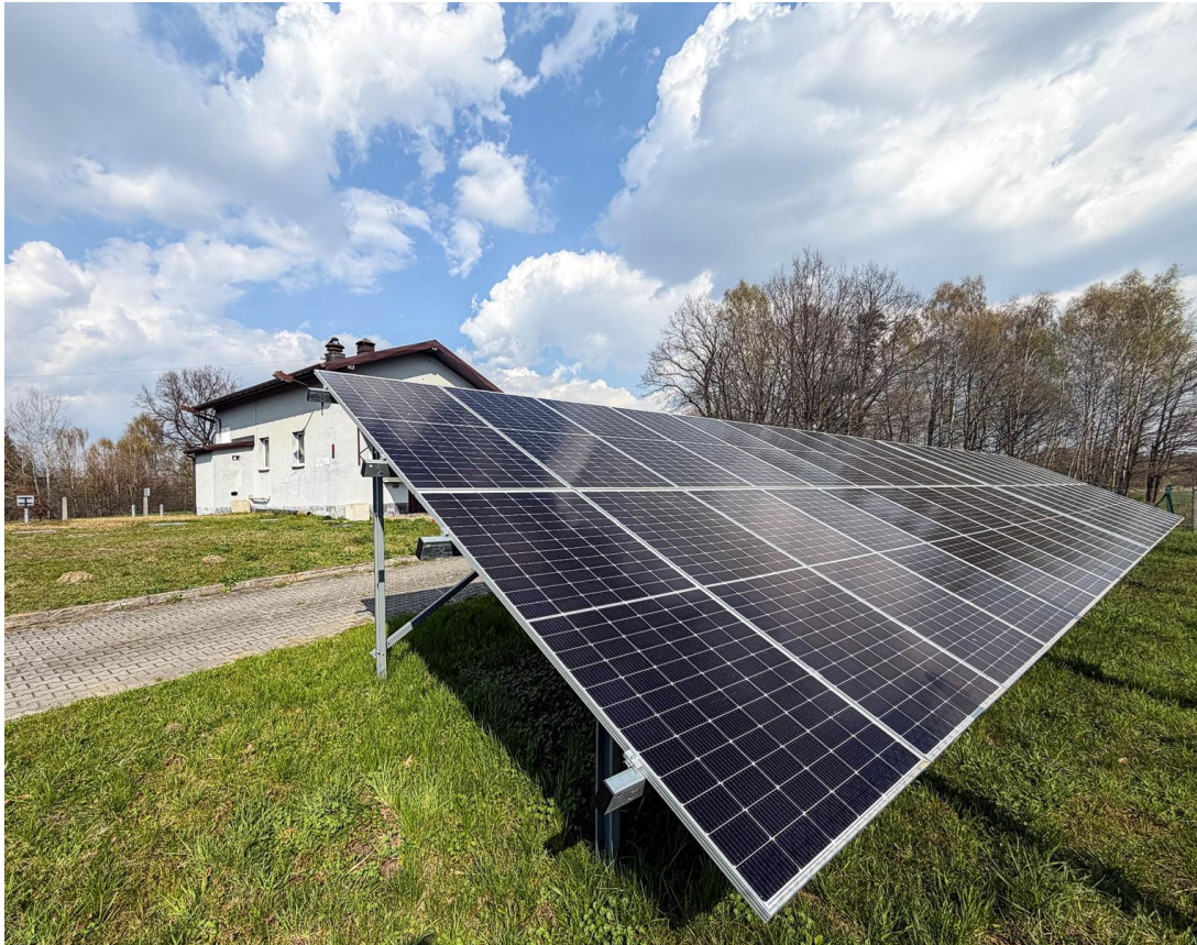
Oczyszczalnia ścieków Międzyrzecze, ul. Międzyrzeczna
