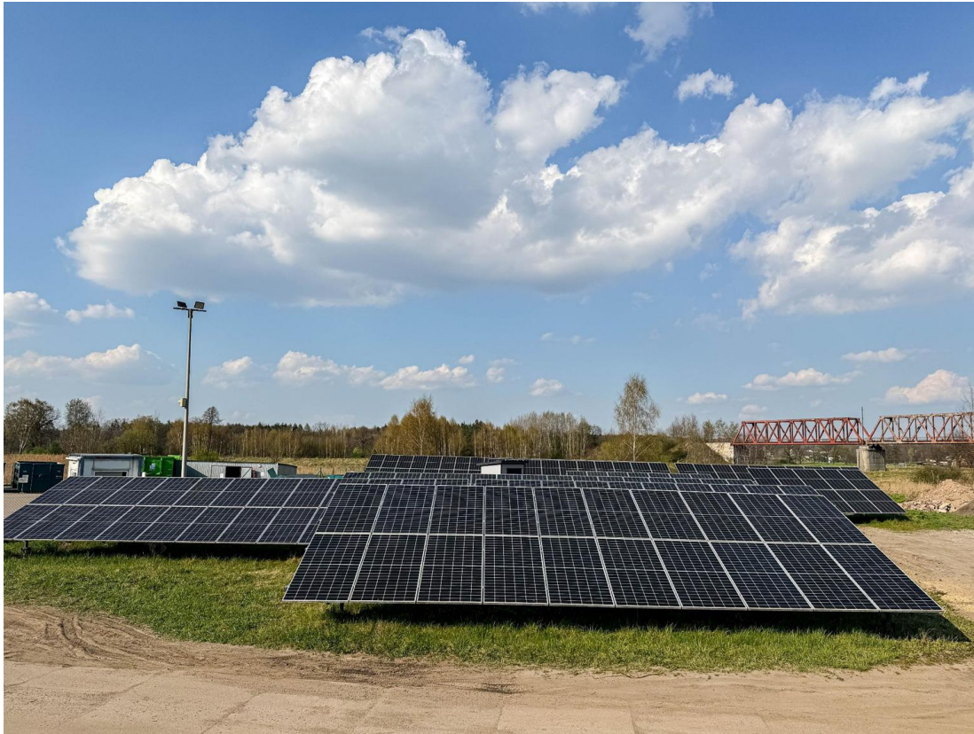
Oczyszczalnia ścieków Bojszowy, ul. Gościnną
