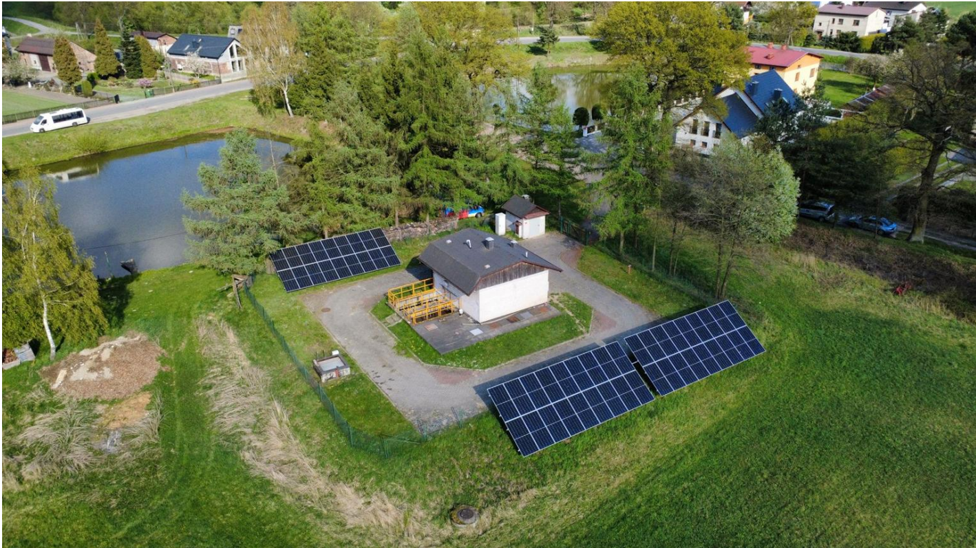
Oczyszczalnia ścieków Jedlina, ul. Wolska 6
